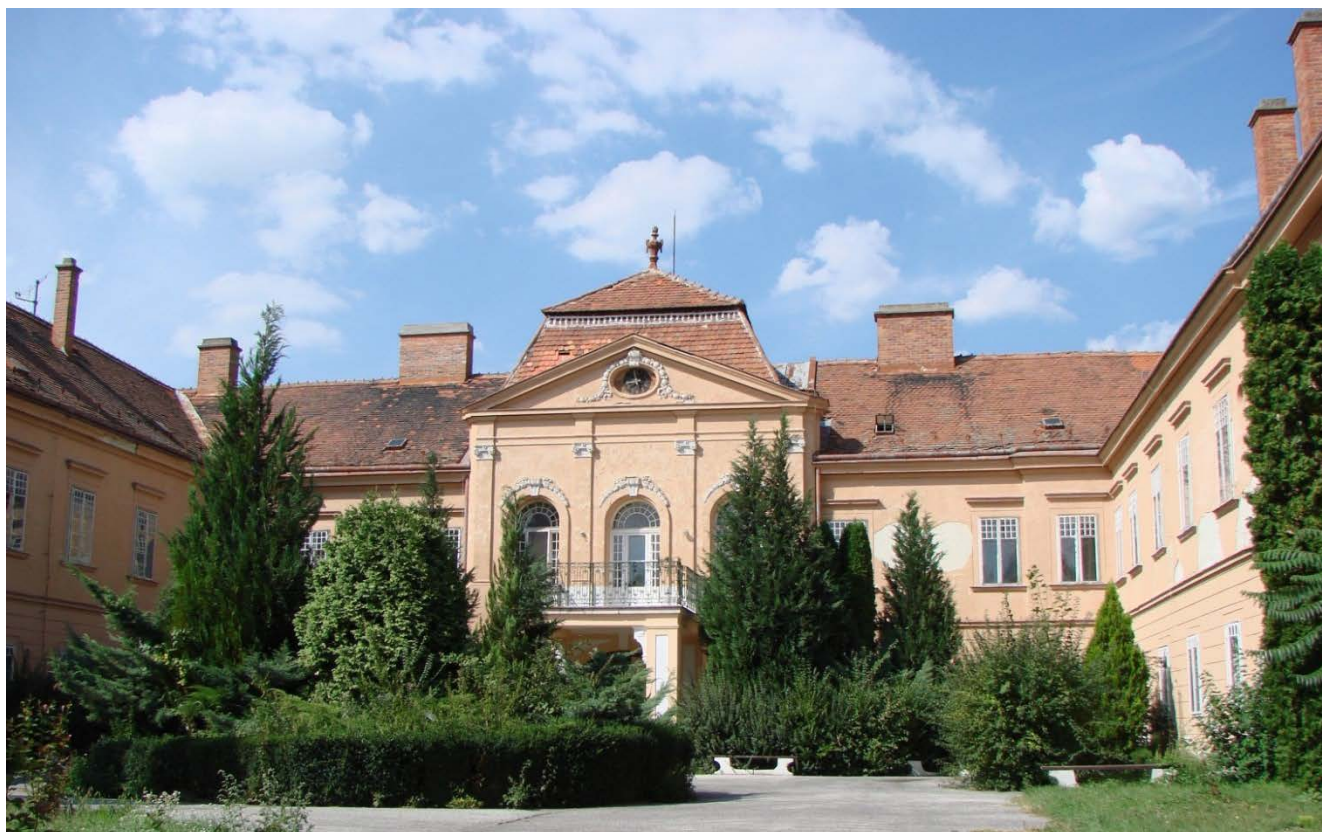
Nádvorie kaštiela v roku 2007, pár mesiacov pred začatím rekonštrukcie
